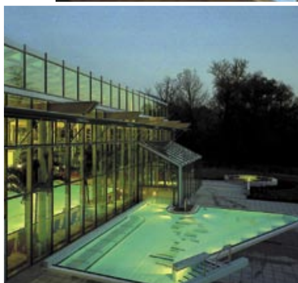
Ausschwimmbecken; Kurzentrum Heilbad Heiligenstadt
